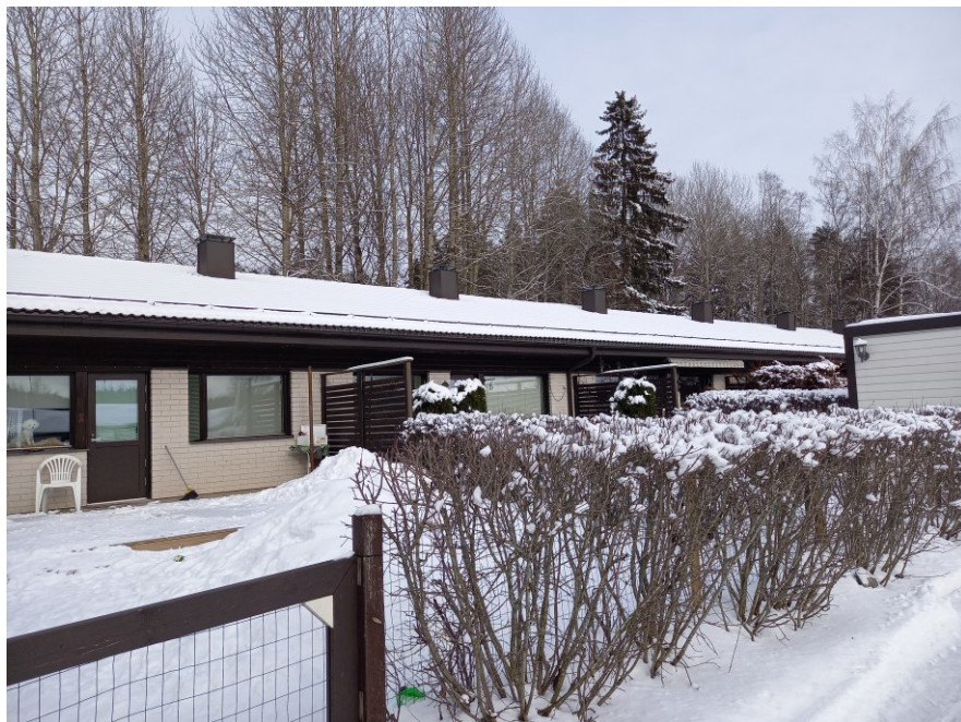
Kuva 1. Rakennus A, asuntopihoja
